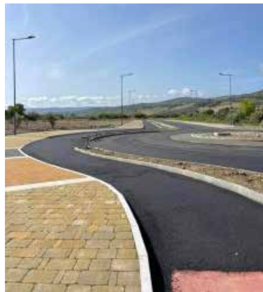
Nuovo tratto di lungomare
